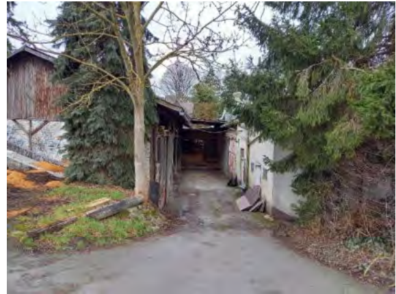
Abb. 13 Sägewerk (links) und Wohnhaus (rechts).
