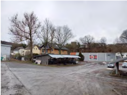
Abb. 4 Blick auf die Lagerflächen, den Unterstand und die Eschen an der westlichen Grundstücksgrenze.
