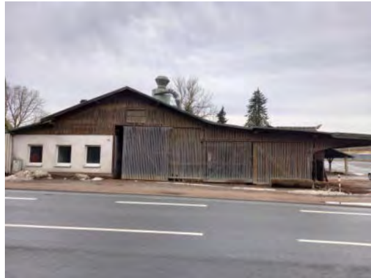
Abb. 5 Blick auf das Sägewerk von Norden.
