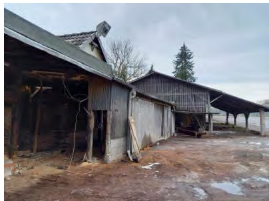
Abb. 9 Blick auf das Sägewerk von Norden.
