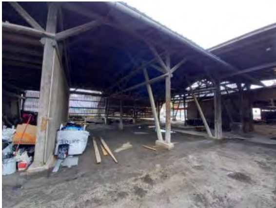
Abb. 14 Lagerhalle des ehemaligen Sägewerkes.
