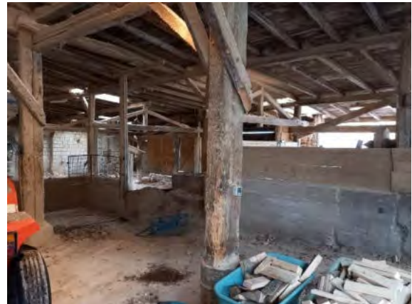
Abb. 15 Innenansicht des ehemaligen Sägewerkes.
